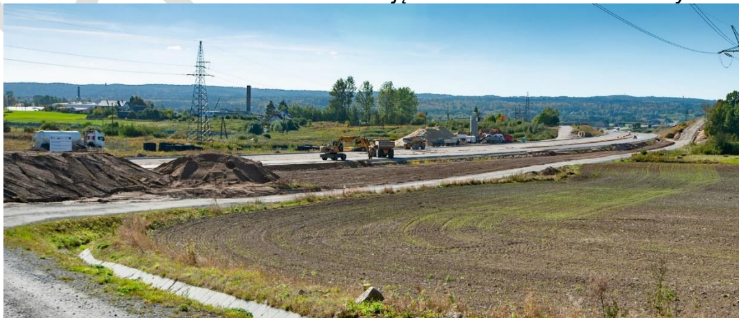
Zdjęcie 1. Budowa obwodnicy Sianowa
