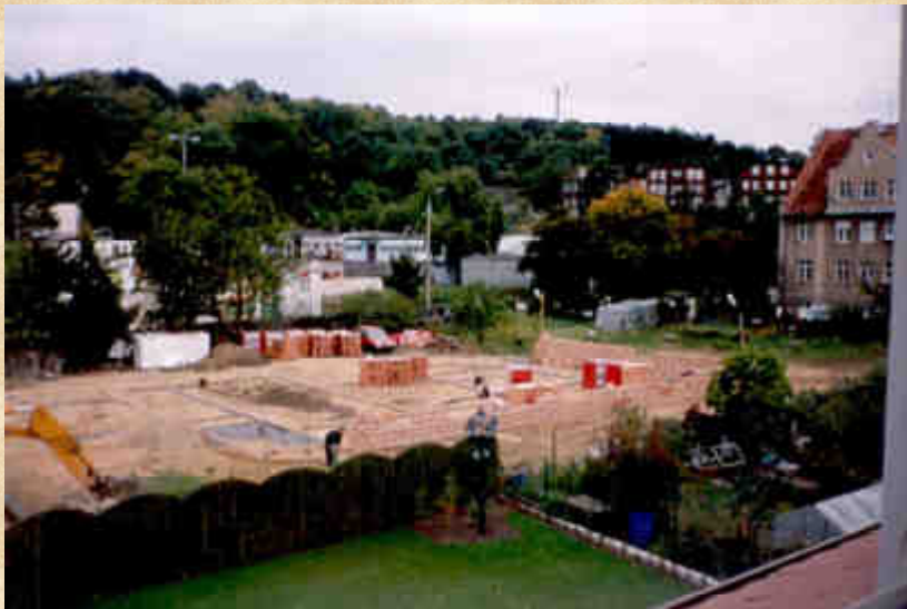
Budowa Domu Hospicyjnego
